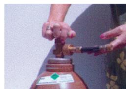
**7** Handrad vom Flaschen-Absperrventil schließen
